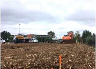
Décaissement et pose du lit de gravier de la plateforme végétale 2
